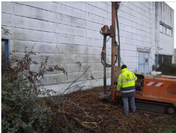
Figure 27 : Vue de la réalisation du sondage S81
