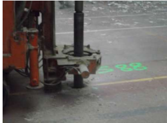
Figure 44 : Vue de la réalisation du sondage S88
