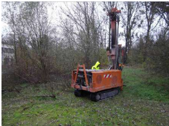
Figure 49 : Vue de la réalisation du sondage S93
