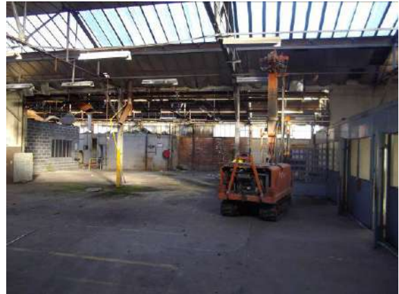
Figure 20 : Vue de réalisation du sondage S76
