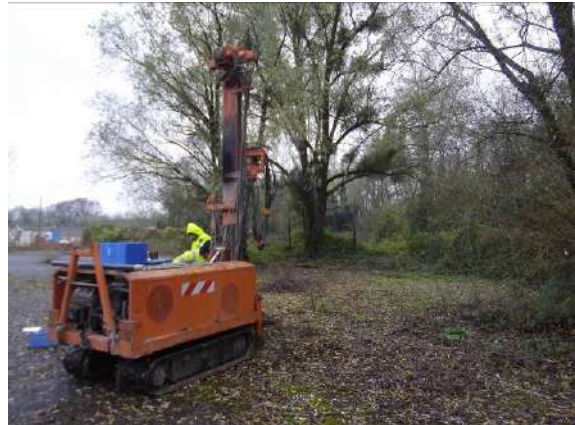
Figure 8 : Vue de la réalisation du sondage S69
