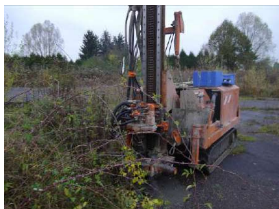
Figure 12 : Vue de la réalisation du sondage S71
