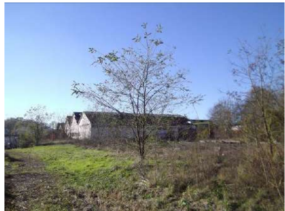
Figure 22 : Vue des anciens bâtiments encore présents sur l'ensemble Nord-Ouest
