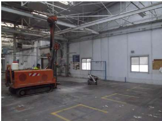
Figure 45 : Vue de la réalisation du sondage S89
