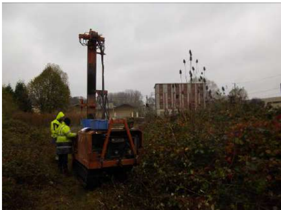
Figure 9 : Vue de la réalisation du sondage S70
