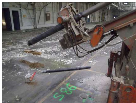
Figure 42 : Vue de la réalisation du sondage S86
