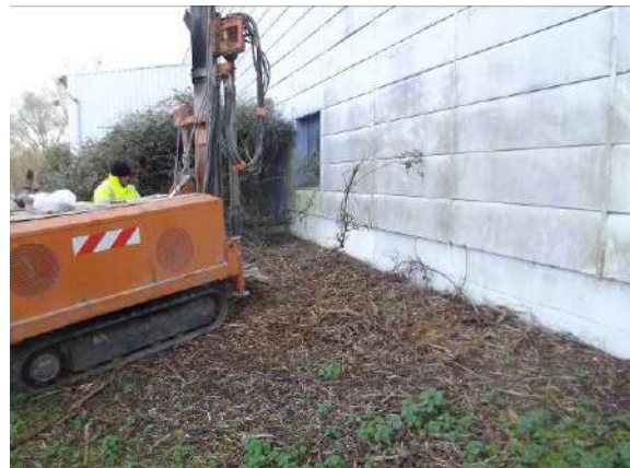
Figure 28 : Vue de la réalisation du sondage S81
