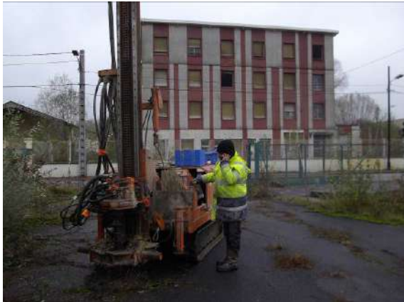
Figure 13 : Vue de la réalisation du sondage S72
