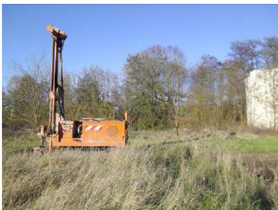
Figure 23 : Vue de la réalisation du sondage S78
