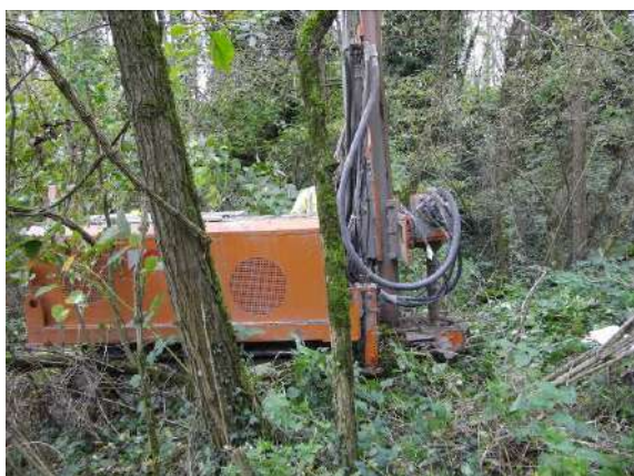
Figure 5 : Vue de la réalisation du sondage S67
