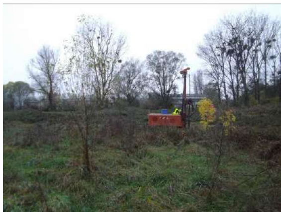
Figure 52 : Vue de la réalisation du sondage S96
