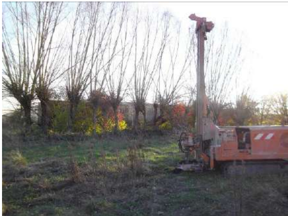
Figure 15 : Vue de la réalisation du sondage S73
