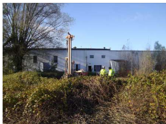
Figure 48 : Vue de la réalisation du sondage S92
