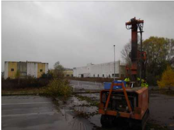
Figure 61 : Vue de la réalisation du sondage S102
