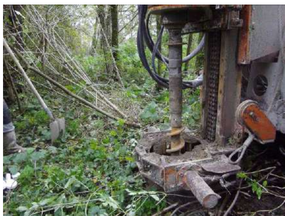
Figure 6 : Vue de la réalisation du sondage S67
