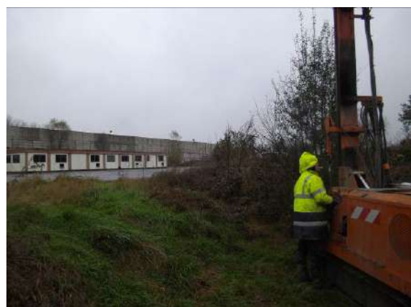
Figure 66 : Vue de la réalisation du sondage S106
