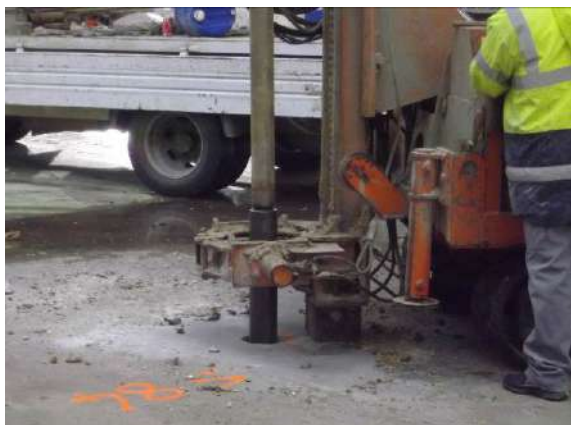
Figure 37 : Vue de la réalisation du sondage S84
