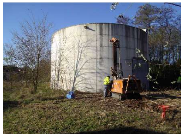
Figure 24 : Vue de la réalisation du sondage S79
