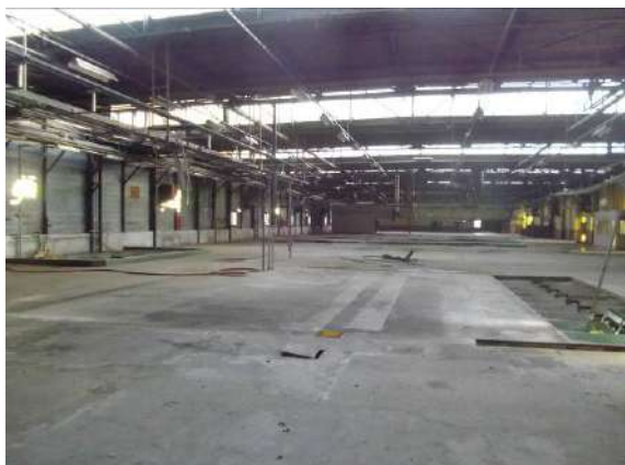
Figure 55 : Vue de l'intérieur de l'ancien bâtiment encore présent sur l'ensemble Centre-Est
