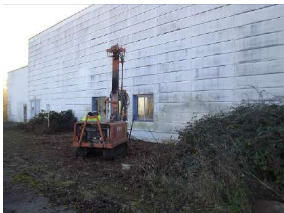
Figure 34 : Vue de la réalisation du sondage S83
