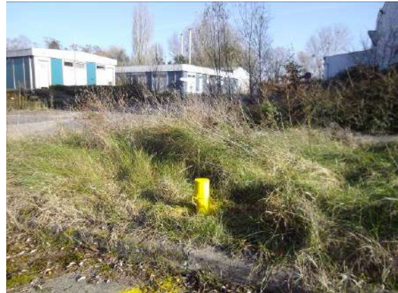
Figure 86 : Vue du capot cadenassé du piézomètre MW4/13
