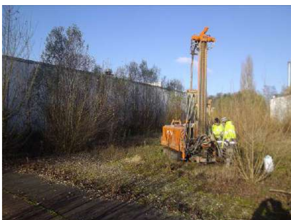
Figure 47 : Vue de la réalisation du sondage S91
