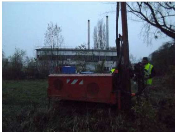
Figure 50 : Vue de la réalisation du sondage S94
