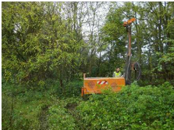
Figure 1 : Vue de la réalisation du sondage SPz 1
