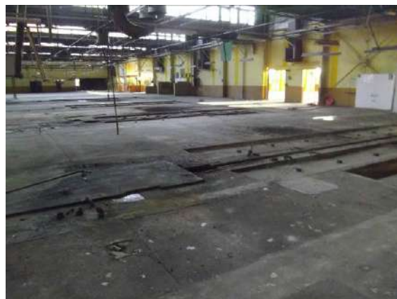
Figure 56 : Vue de l'intérieur de l'ancien bâtiment encore présent sur l'ensemble Centre-Est
