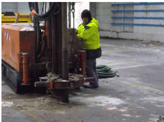
Figure 33 : Vue de la réalisation du sondage S82
