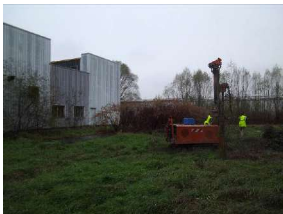
Figure 54 : Vue de la réalisation du sondage S98
