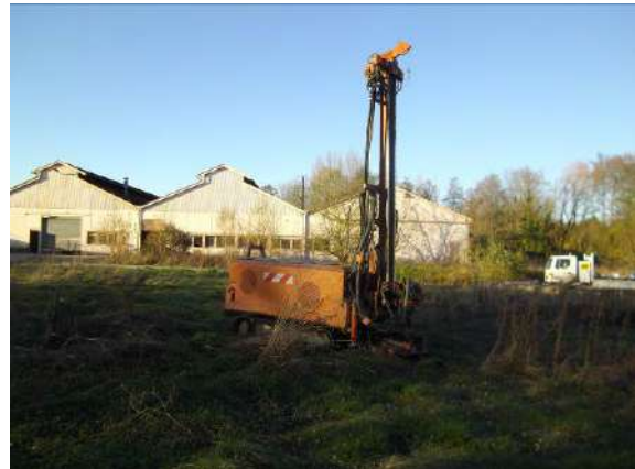
Figure 16 : Vue de la réalisation du sondage S74
