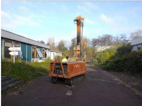
Figure 25 : Vue de la réalisation du sondage S80
