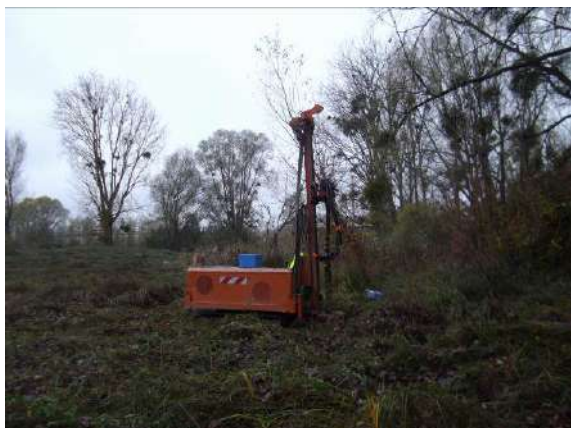
Figure 51 : Vue de la réalisation du sondage S95
