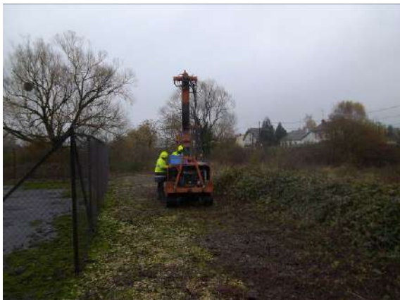
Figure 63 : Vue de la réalisation du sondage S104
