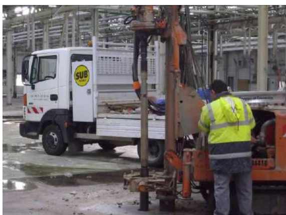
Figure 35 : Vue de la réalisation du sondage S84
