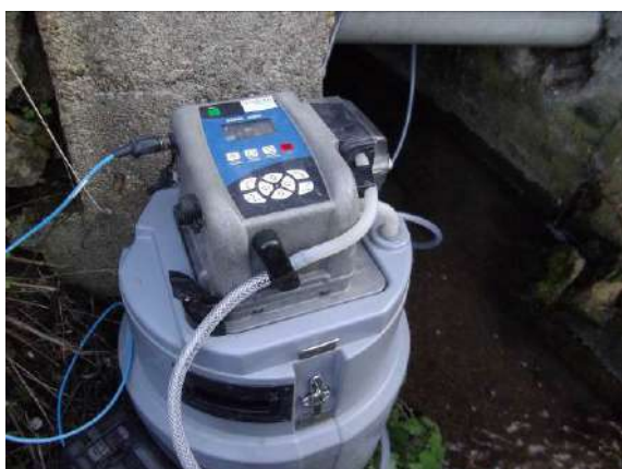
Figure 83 : Vue de l'échantillonneur portable pour la réalisation du prélèvement moyen sur 24 heures
