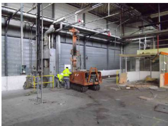
Figure 59 : Vue de la réalisation du sondage S101
