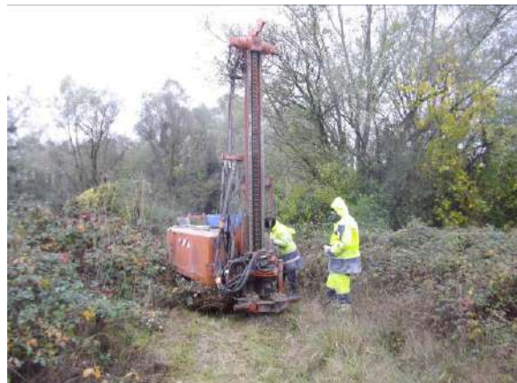
Figure 10 : Vue de la réalisation du sondage S70
