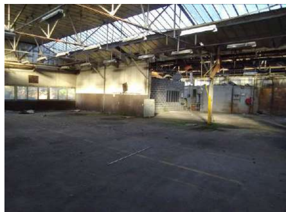
Figure 18 : Vue de l'intérieur de l'ancien bâtiment encore présent sur l'ensemble Nord-Ouest
