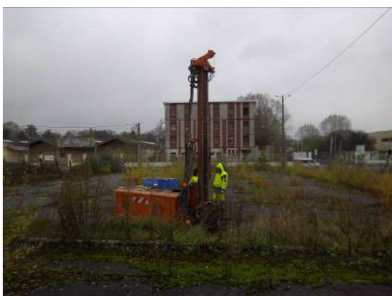
Figure 11 : Vue de la réalisation du sondage S71
