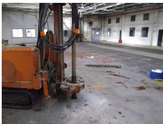
Figure 36 : Vue de la réalisation du sondage S84
