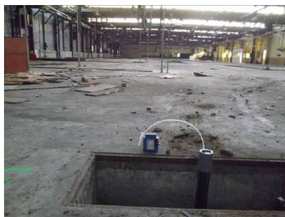
Figure 78 : Vue de la réalisation du prélèvement sur le piézair Pzair S101
