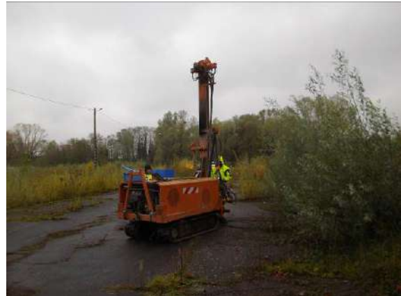
Figure 14 : Vue de la réalisation du sondage S72
