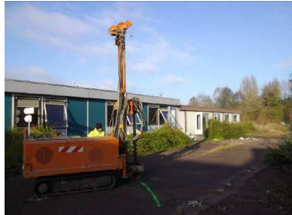
Figure 26 : Vue de réalisation du sondage S80
