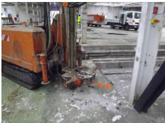
Figure 39 : Vue de la réalisation du sondage S85
