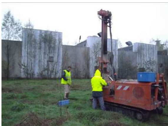
Figure 53 : Vue de la réalisation du sondage S97
