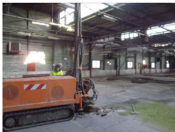
Figure 58 : Vue de la réalisation du sondage S100
