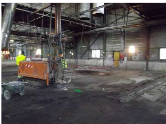
Figure 57 : Vue de la réalisation du sondage S99
