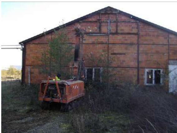
Figure 21 : Vue de la réalisation du sondage S77
