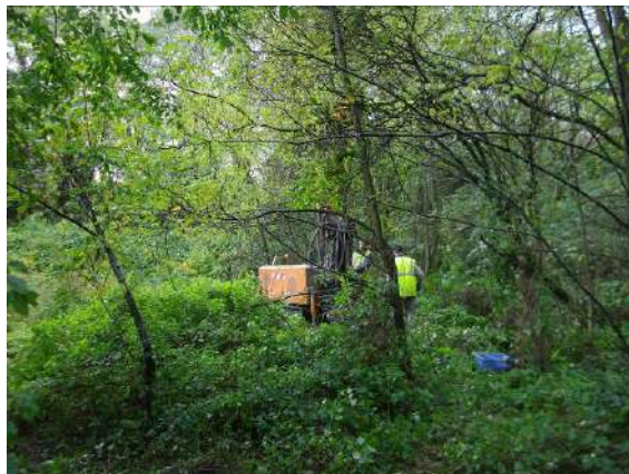
Figure 2 : Vue de la réalisation du sondage SPz 1
