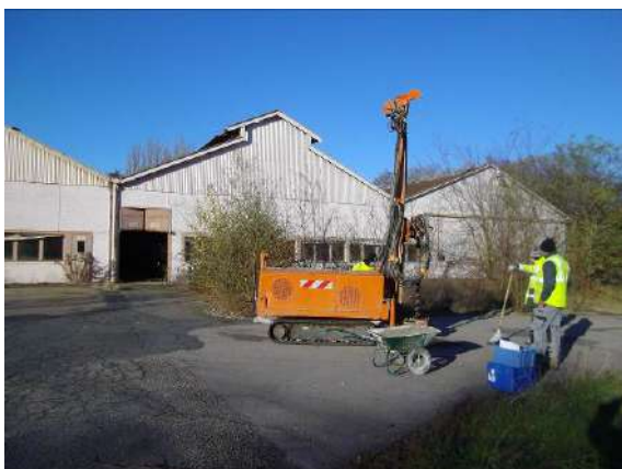
Figure 17 : Vue de la réalisation du sondage S75
