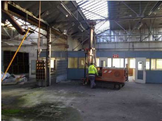
Figure 19 : Vue de la réalisation du sondage S76
