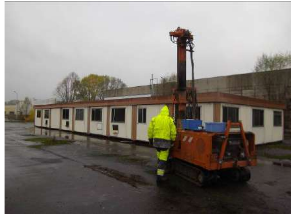
Figure 62 : Vue de la réalisation du sondage S103
