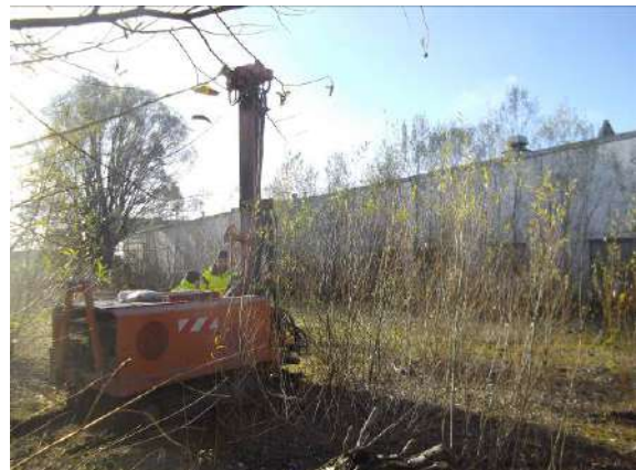
Figure 46 : Vue de la réalisation du sondage S90
