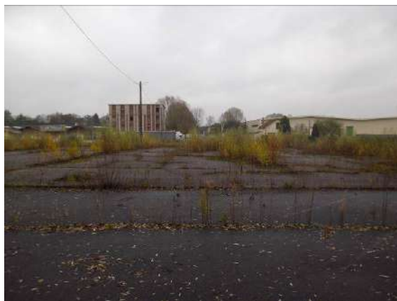
Figure 4 : Vue du parking Ouest
