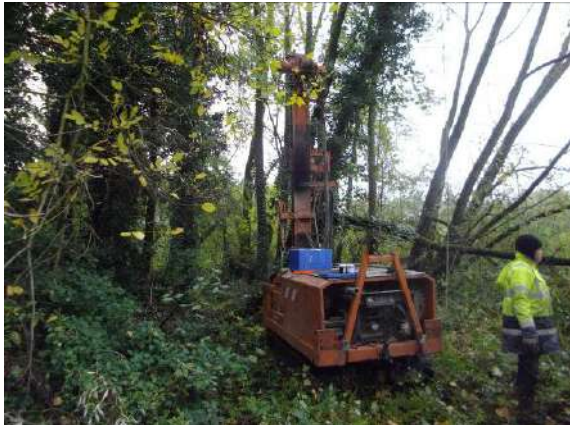
Figure 7 : Vue de la réalisation du sondage S68
