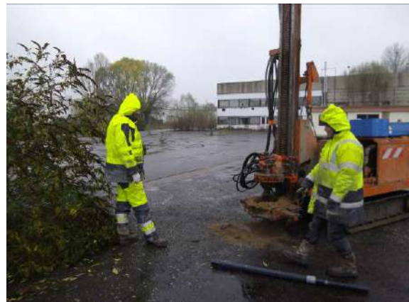
Figure 64 : Vue de la réalisation du sondage S105
